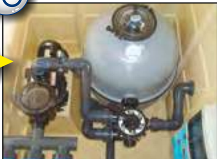
10 RÉALISATION DU LOCAL TECHNIQUE
