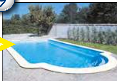
9 POSE DES MARGELLES
