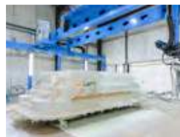
Pose des renforts + résine de protection
