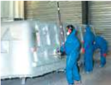
Pose des renforts + résine de protection
