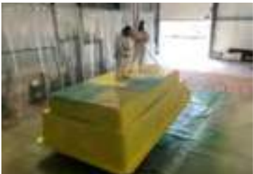
Application Gel Coat sur le moule
