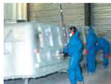
Pose des renforts + résine de protection
