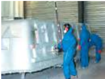
Pose des renforts + résine de protection
